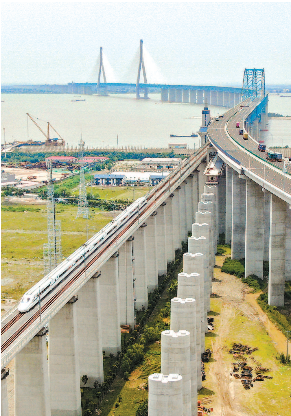
▲ 2020 年 7 月 1 日，沪苏通铁路开通运营，作为这条铁路的重要控制性工程，沪苏通长江公铁大桥同步建成通车。上午 11 时 32 分，南通西站发出首列至上海的动车驶上沪苏通长江公铁大桥 本报记者 陈梦泽 摄
