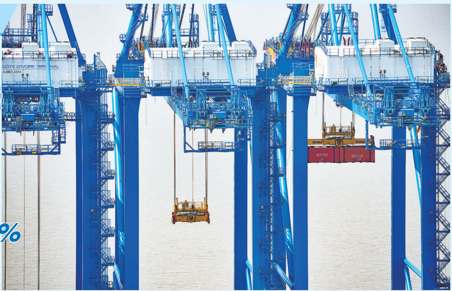
■ 振华重工长兴基地码头,工人在焊接桥吊大梁
