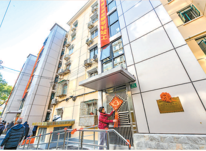
徐汇区凌云街道十二台既有住宅加装电梯竣工交付
