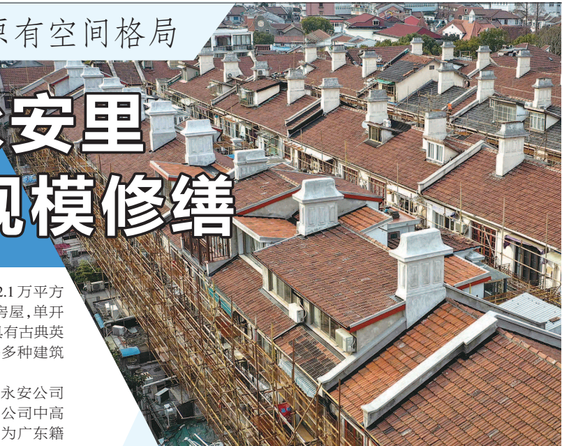
“红色里弄”永安里开启修缮工程
