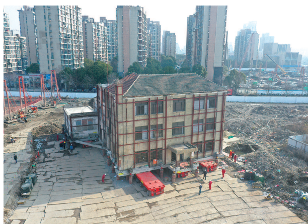
暨南大学科学馆旧址车载平移顺利到位 本报记者 张龙 通讯员 陈时俊 摄
