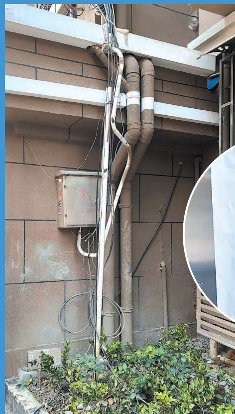
▲ 25号居民楼底楼墙壁上“吸附”了一个私家充电桩 本版摄影 徐驰
