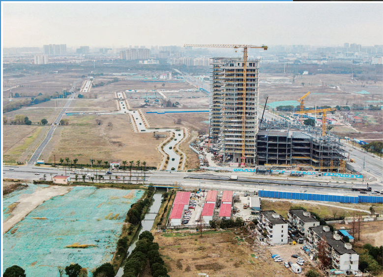
■ 南大地区总面积高达629.80公顷的土地已经拆平
