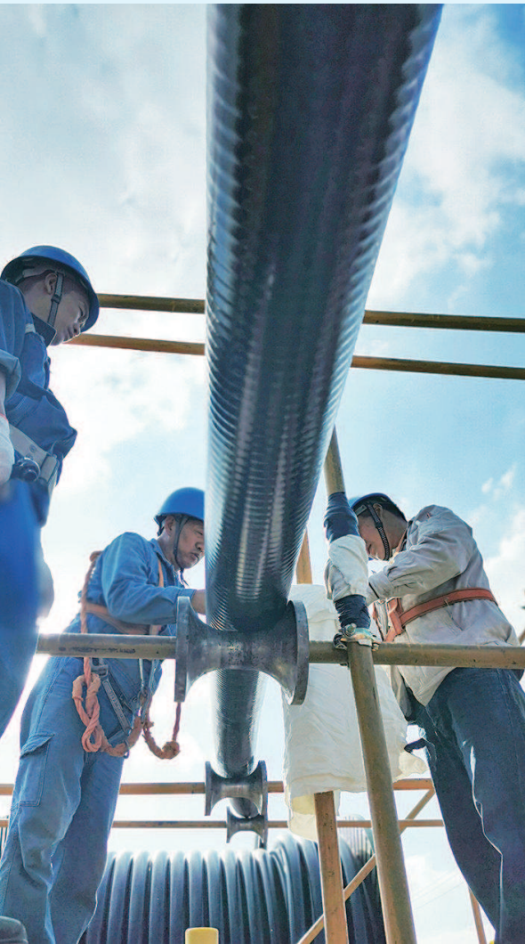
■ 世界首条 35 千伏公里级超导电缆试拉试验现场
