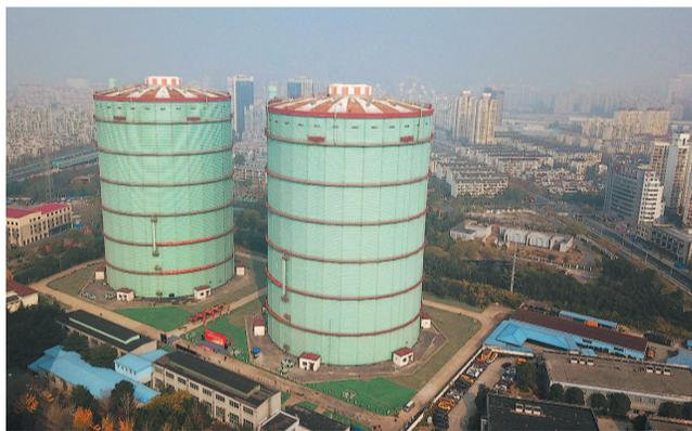
架的拆除,以及气柜、管道内气体置换等工序。整个拆除工程预计为期1年。隧道股份大渡河路项目负责人表示,拆除“大绿罐”需要分多步进行:首先,需要将罐内的天然气进行置换;其次,要对气柜的整体结构情况进行评估;最后,再对拆除的钢
