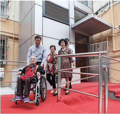
■ 徐汇区长桥四村加装电梯后,103岁的金阿婆能顺利下楼了 本报记者 张龙 摄
