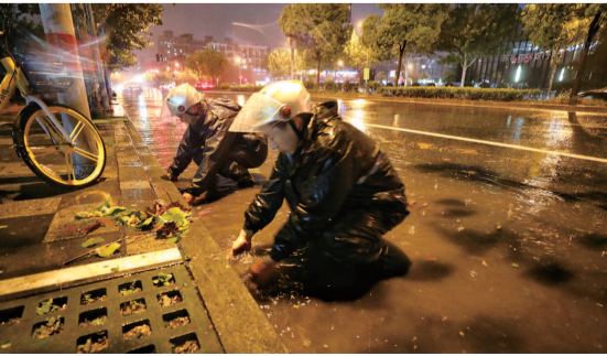
昨晚10时50分，普陀区长征镇网格巡查员在祁连山南路清理街边排水沟 本报记者 张龙 摄
