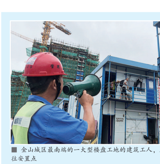
金山城区最南端的一大型楼盘工地的建筑工人,上午开始有序撤离安置点 庄毅摄
