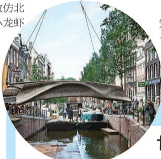
近日，世界首座3D打印钢制桥梁“空降”阿姆斯特丹红灯区，荷兰王后和剪彩机器人现场为其揭幕，正式向公众开放2年。这座桥长12.2米，宽6.3米，重6吨，采用S形流线设计。在4个机器人的帮助下，打印花掉了4500公斤不锈钢和6个月时间。除了引人注目的设计外，它还设有隐藏的传感器，收集有关其
