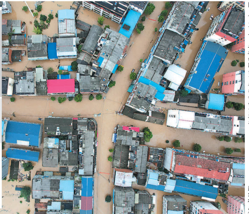
八月十二日拍摄的随州市柳林镇受灾现场
