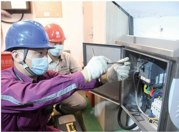
■ 维修人员正在更换低压配电箱内的开关
