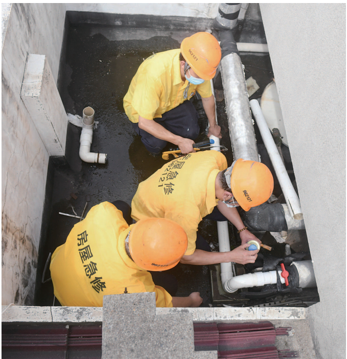
■ 工作人员在屋顶维修漏水水箱 本报记者 陶磊 摄
