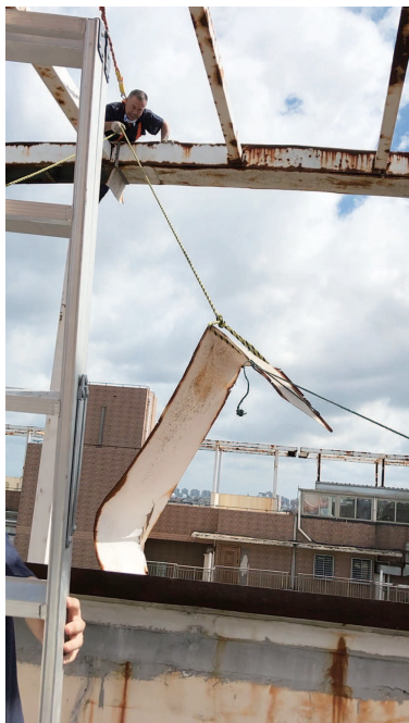
工人在高空切割楼顶钢条
