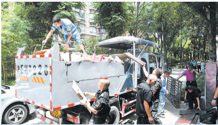
■ 工作人员在装运地下室拆出的各类杂物 本报记者 孙中钦 摄
