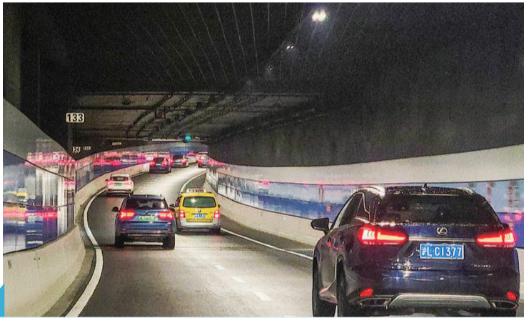
■ 目前外滩隧道照明节能改造基本完成，已没有“一半是明一半是暗”的现象 本报记者 陈梦泽 摄
