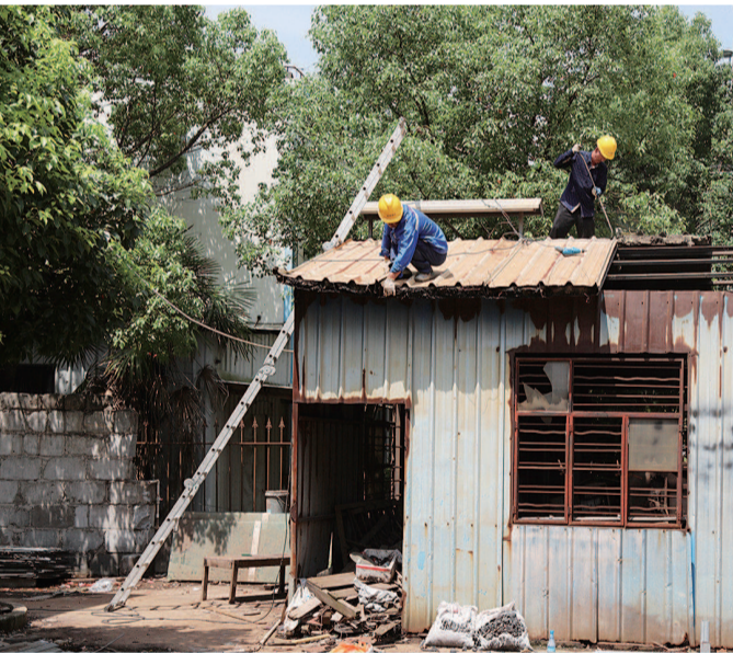
■ 工人在拆除违法搭建的彩钢棚 本报记者 王凯 摄
