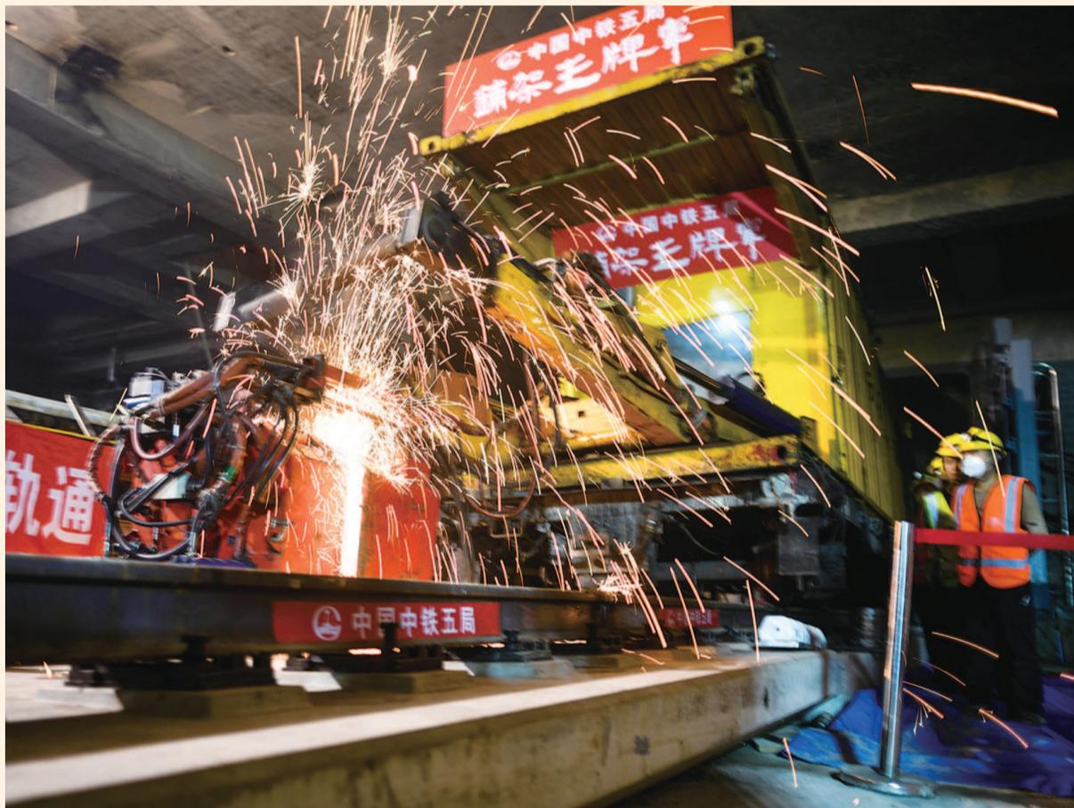
■昨天下午,位于上海轨交14号线静安寺站的最后一对25米钢轨被施工人员焊接连通。这标志着14号线全线轨道顺利贯通,为下一步开通试运营奠定了基础
