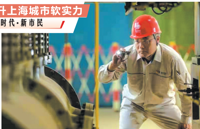
■ 韩浩江夜巡变电站
