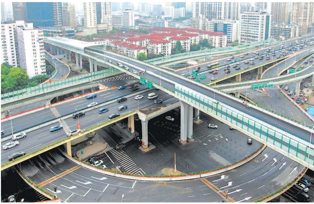
■ 北横通道西段今天通车,“飞跃”南北高架的这一跨是施工中最难点
