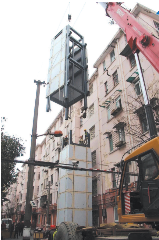
■ 鹤明小区21号一体化吊装电梯
