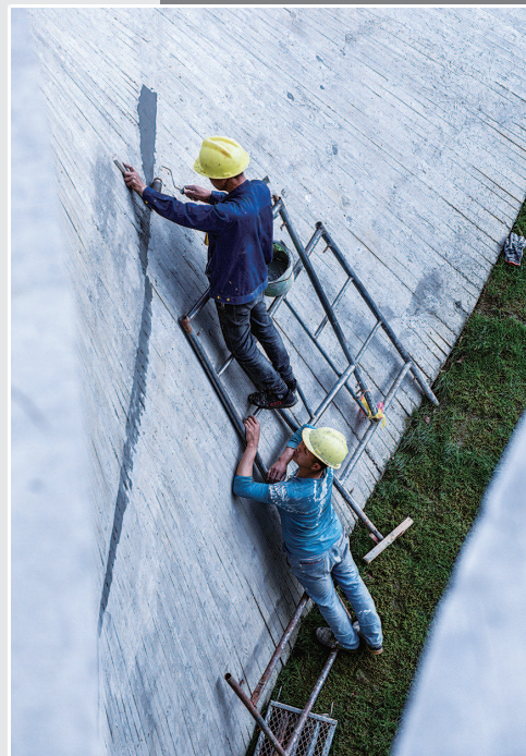
■ 4月中旬,花博小镇的光明未来展厅,施工人员精心修整弧形外立面
