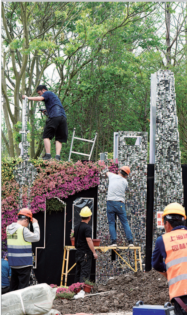
■ 5月11日中午,上海“源梦园”主题馆,几名工人在做场馆入口处的花卉景观
