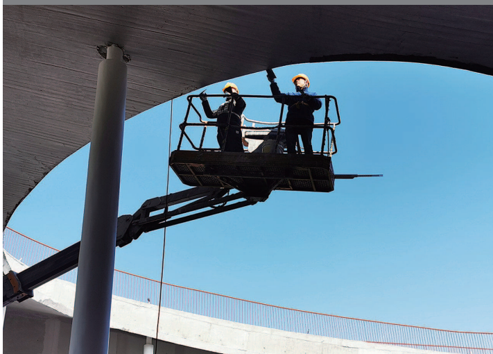
■ 3月2日,花博会世纪馆,两名工程人员正在高空作业
