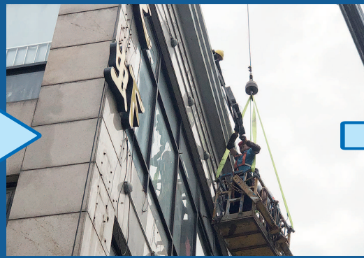
工人正在拆除
