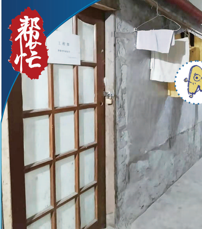
小区地下车库被分隔成一个个房间,装上房门 夏韵 摄
