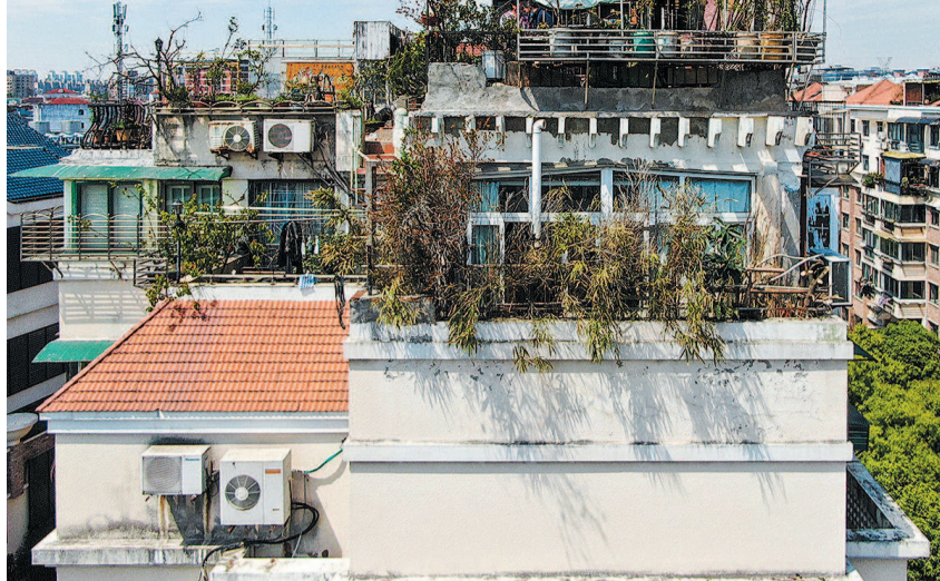
■ 整治中的楼顶“鸟巢”，大树已被移除
