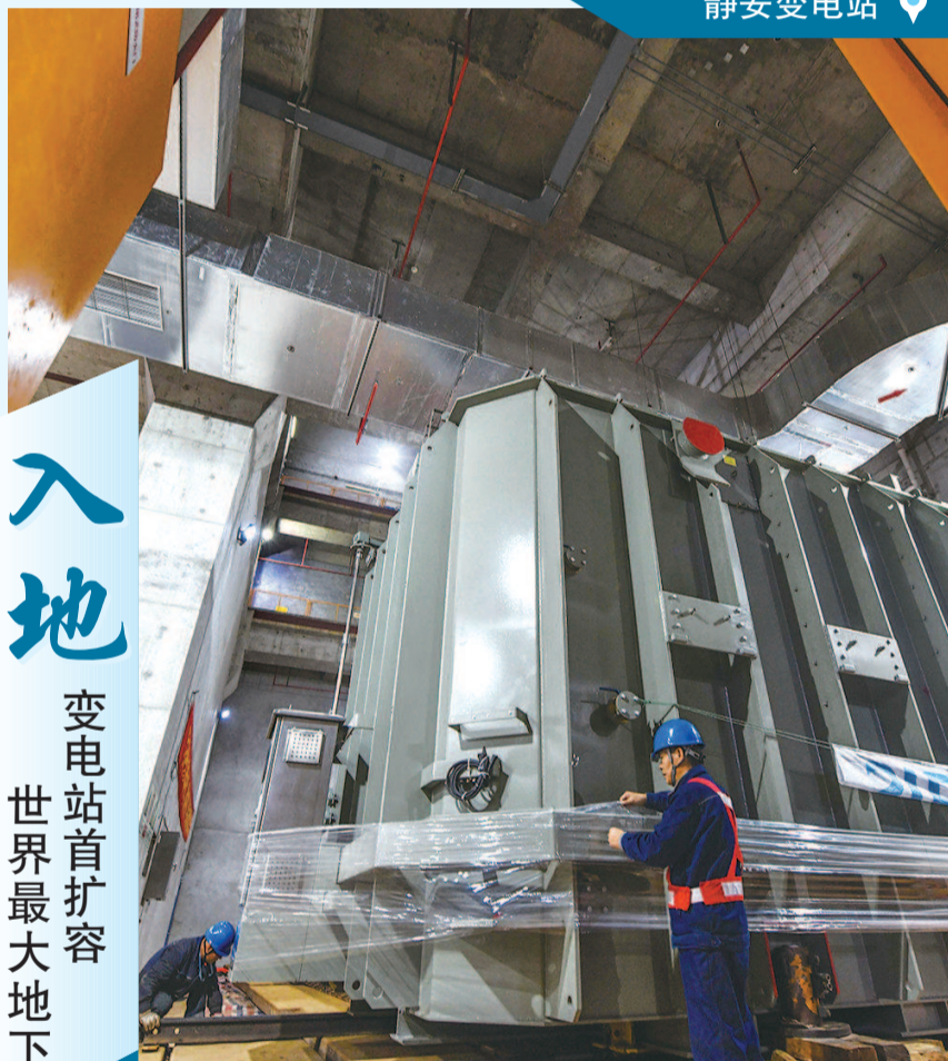
■ 上午,施工人员在为500千伏主变压器做进场就位准备 本报记者 陶磊 摄
