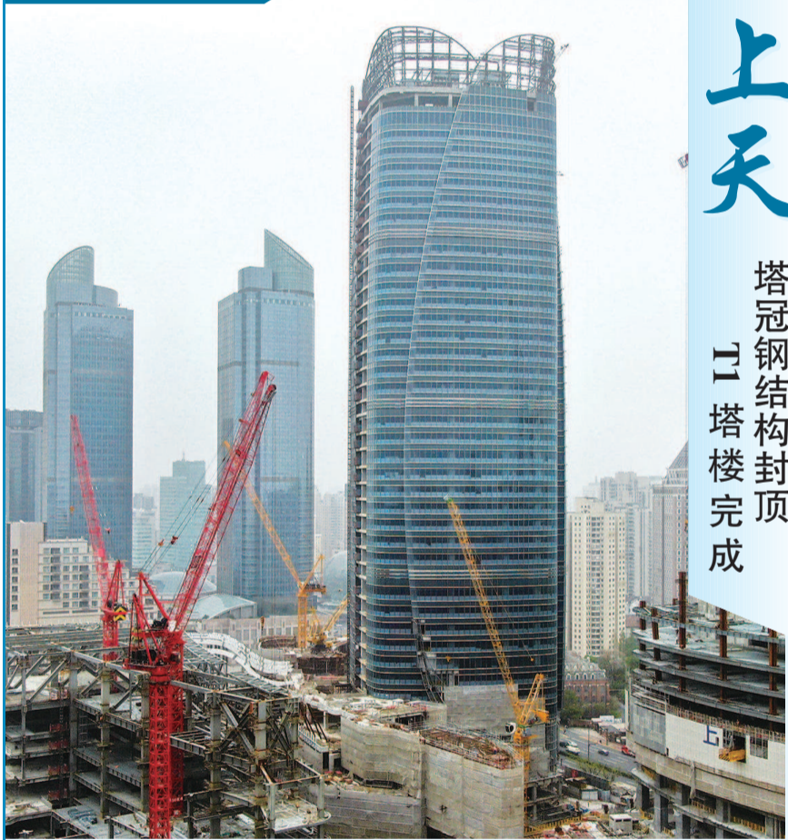
■ T1塔楼共43层,高220米,钢结构总量约6000吨
