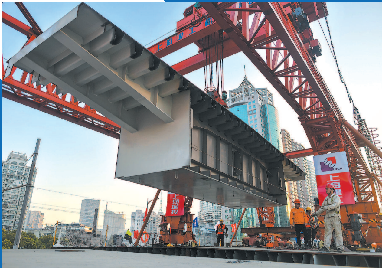
■ 今天上午,长寿路中幅桥最后一块钢箱梁完成吊装,主桥结构合龙
