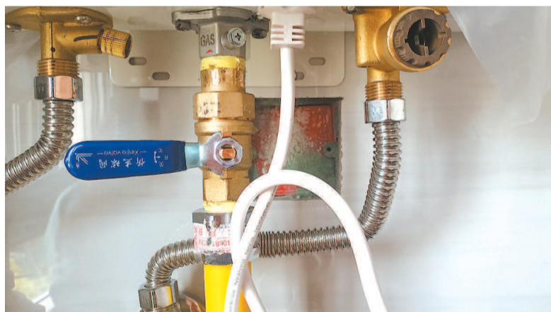
装修毛病一大堆:插座装在燃气管道后成“一级安全隐患”,管道排设时高低和距离不达标
