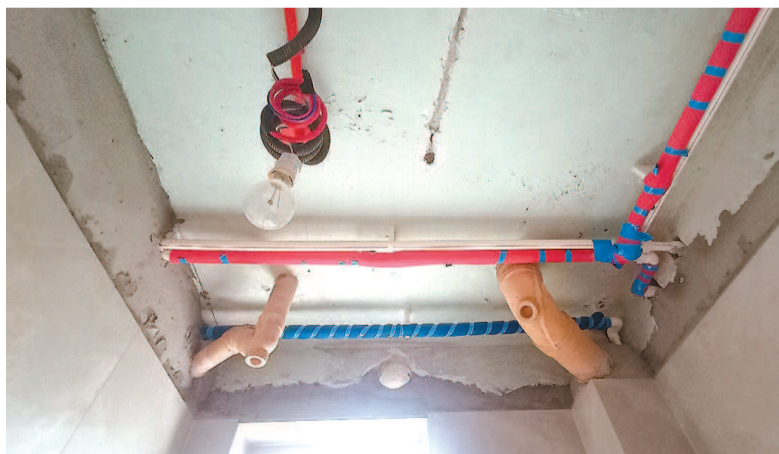
装修毛病一大堆:插座装在燃气管道后成“一级安全隐患”,管道排设时高低和距离不达标
