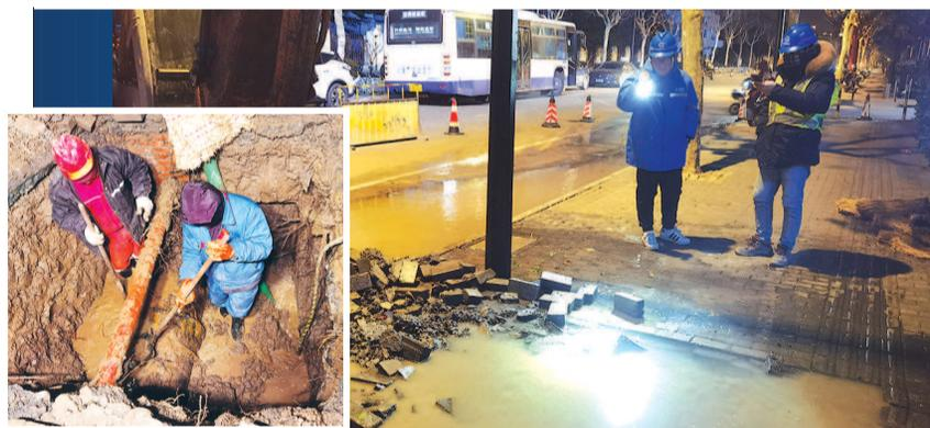
■ 松涛路景明路附近水管爆裂,工人挖深坑连夜抢修
