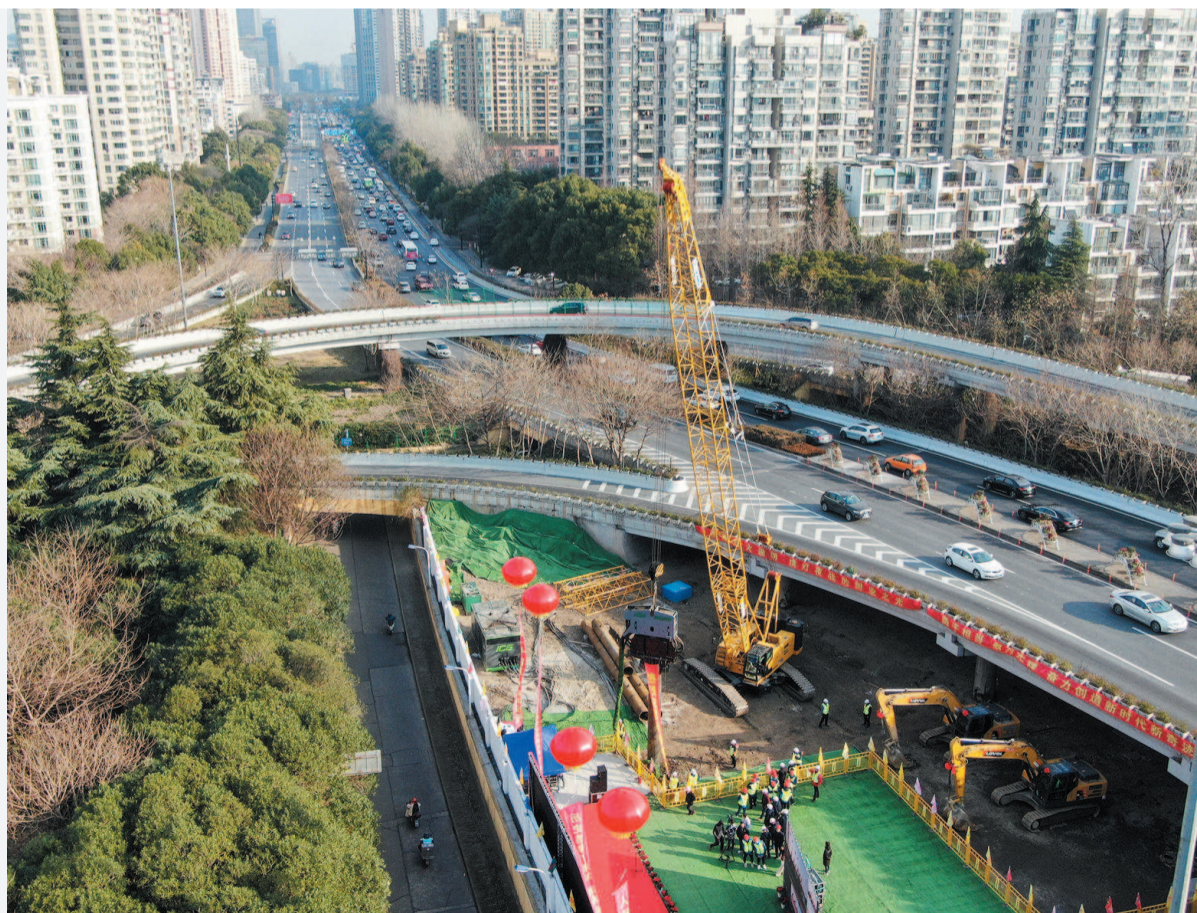
上午 9 时许,随着一根钢管桩由高频免振动植桩机压入地面,杨高路改建工程正式启动
