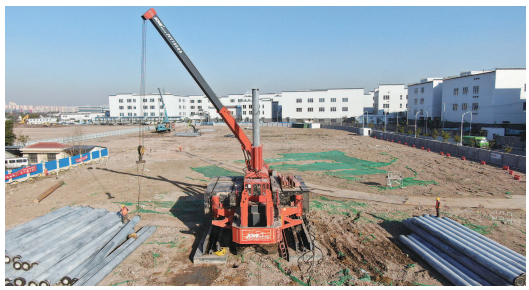
“和记黄埔医药创新药生产基地”建设施工现场 本报记者 徐程 摄
