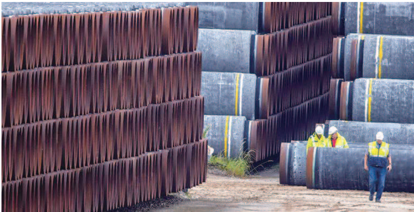
■ “北溪-2”项目在德国的管道铺设工地现场 图 GJ
