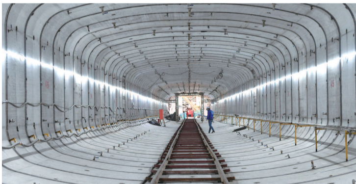
■ 超大断面类矩形顶管双线顺利贯通
