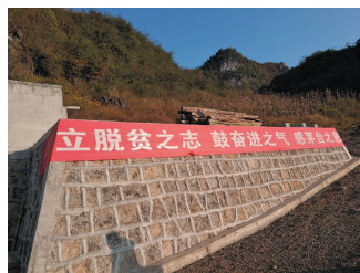
▲茅台集团在道真修建基础设施
