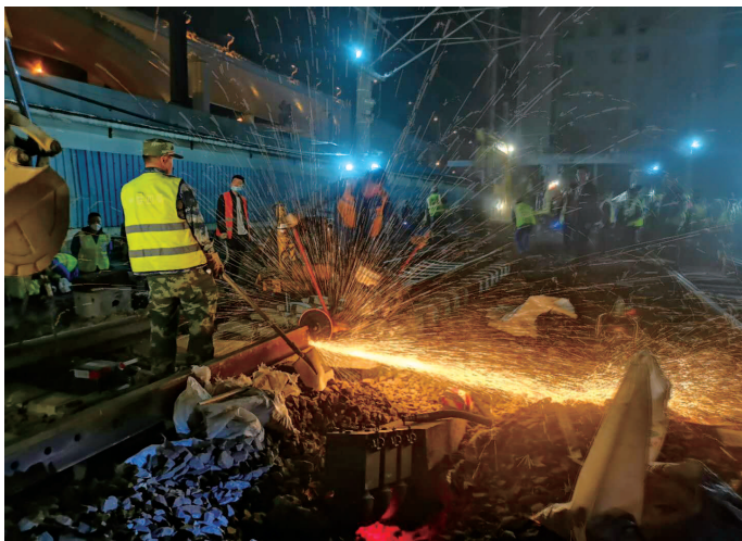
施工现场切割钢轨
