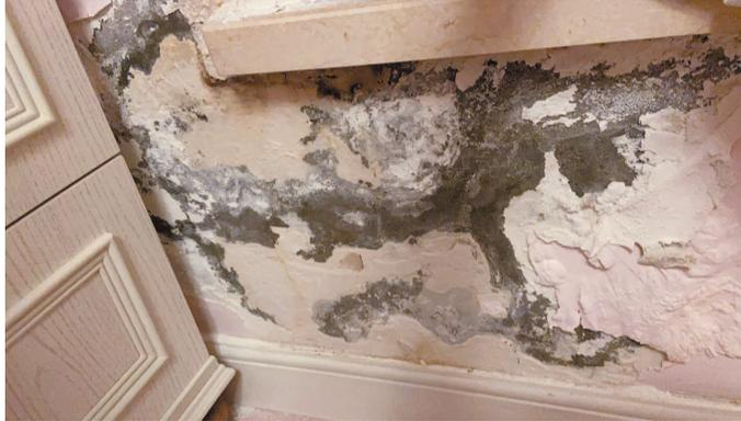
自行修补窗台渗漏水部位, 但又因新的渗漏浸泡发生, 墙皮脱落, 一片斑驳。与此同时, 长年渗漏的房间里霉味严重, 报修无门之下, 不少住户只能选择自行修补。家住 2 号楼 4 层的业主告诉记者: “我已经三次自费修理内墙, 但还是无济于事。”
