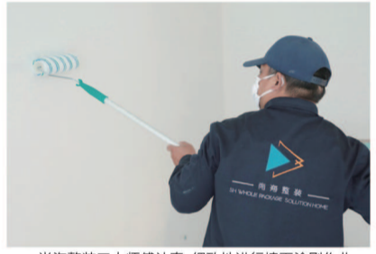
● 尚海整装工人师傅认真、细致地进行墙面涂刷作业。
