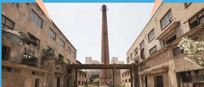
改造前的老厂房
