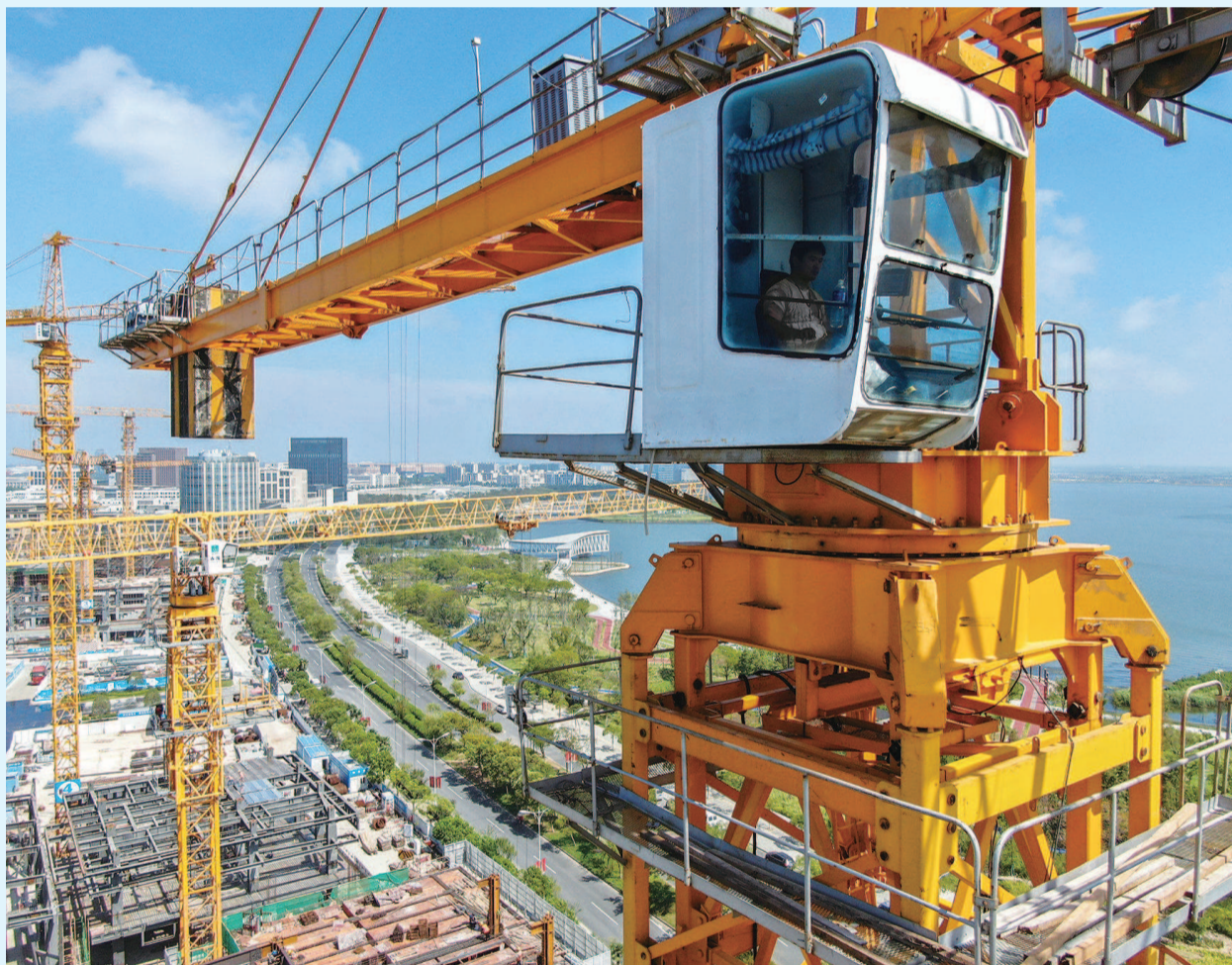
■ 今天上午,滴水湖畔,由中国建筑八局承建的港城广场三期正在加紧建设。该项目包含了上海最美临湖图书馆,将打造为临港文化地标 本报记者 陈梦泽 摄
