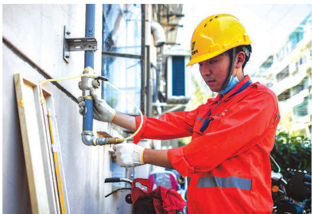
燃气立管改造现场 本报记者 陈梦泽摄
