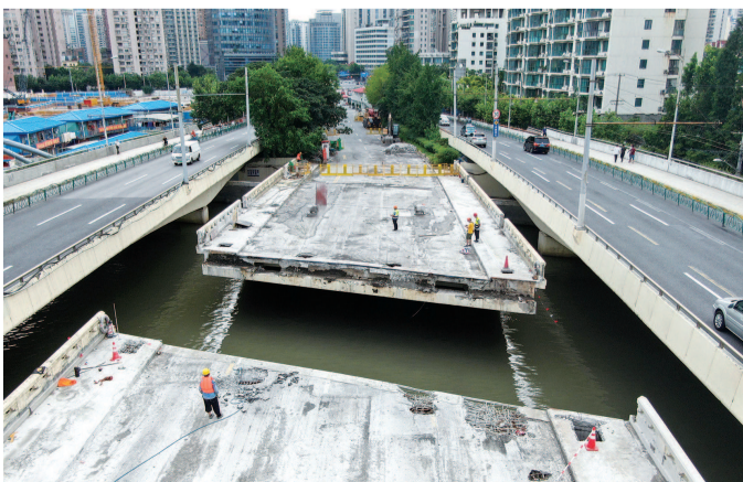
长寿路桥中幅桥改造工程昨天启动
