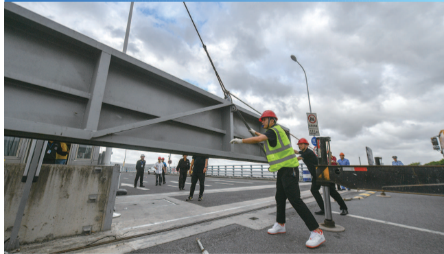
■ 昨天下午,吴淞口国际邮轮港的工作人员将防汛闸门安装到位,以防江水倒灌 本报记者 陈梦泽 摄
