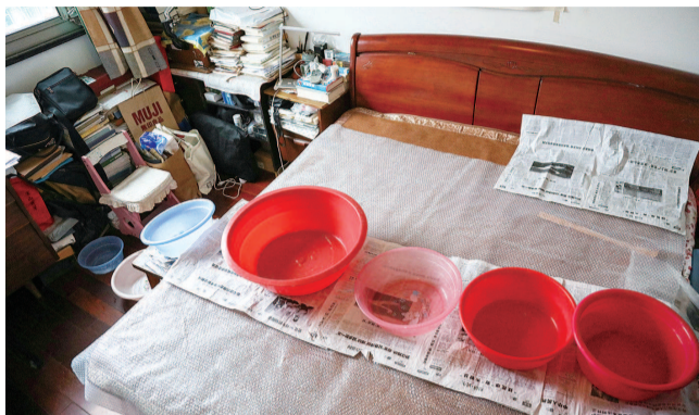
■ 振和公寓漏水,居民在卧室中放了7只脸盆接水
