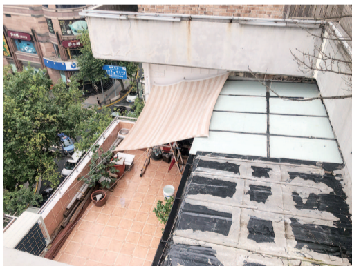
培恩公寓7楼露台上搭出违法建筑
