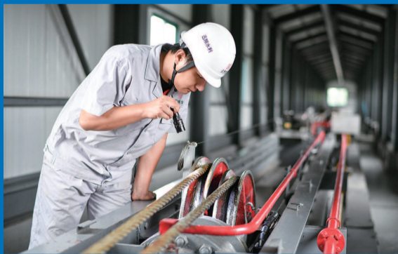
■ 大治河水闸工作人员对水闸进行日常巡检 本报记者 陈梦泽 摄
