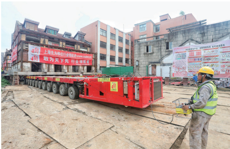
■ 静安安康苑永庆里历史建筑在平移过程中
