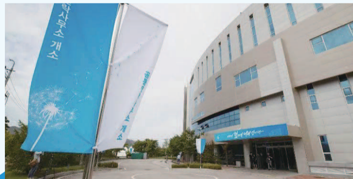
朝韩联络办公室大楼(资料照片)
