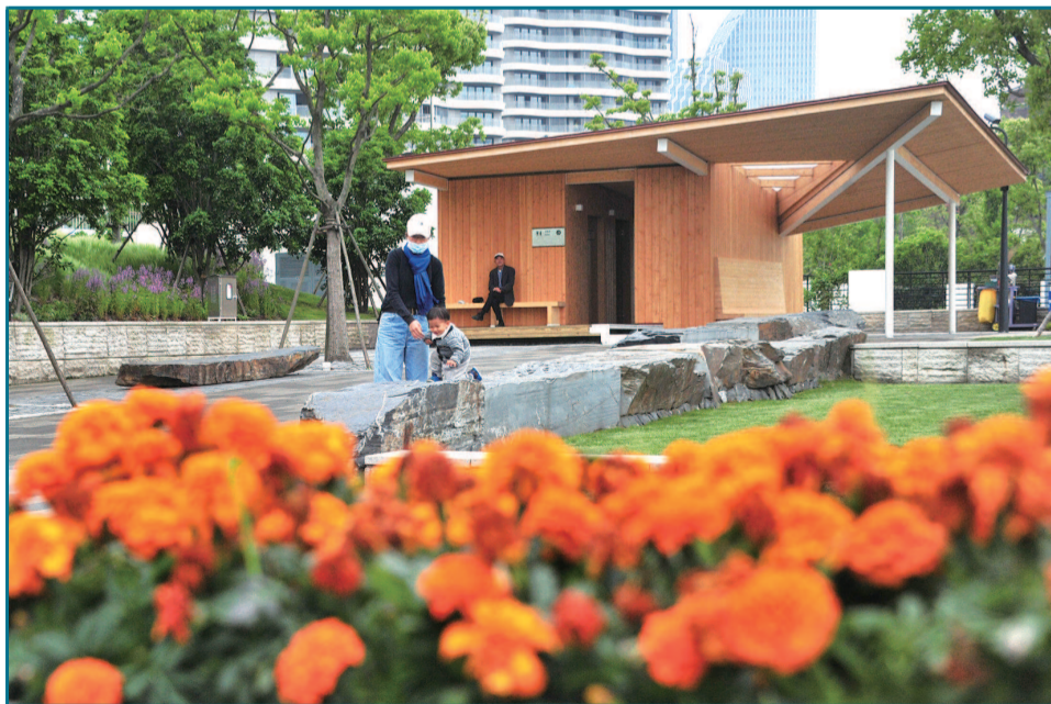
黄浦江东滨江新华绿地和船厂绿地近日新添了3座“望江亭”,并向市民游客开放,东岸滨江服务群众的设施空间网络得到进一步织密,也是对公共服务设施进行补充和完善。望江亭建设以在局部配套设施不足之处形成500米一处的布点密度为原则,实际建筑面积约35平方米,主要有三大功能,即市民游客休憩、观景和公共服务。 杨建正 摄影报道
